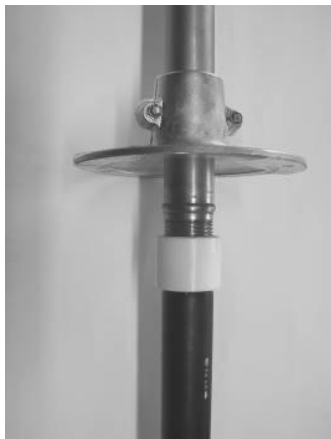
Kuva 8: Runkoputken kiinnitys nousuputkeen
