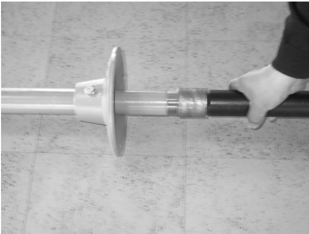
Kuva 9: Runkoputken kiinnitys nousuputkeen
